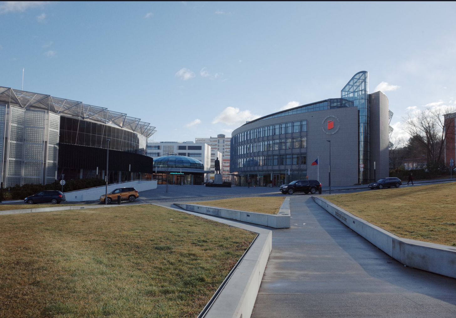
學校主建築外觀，國際辦公室和圖書館都在右側那棟建築
